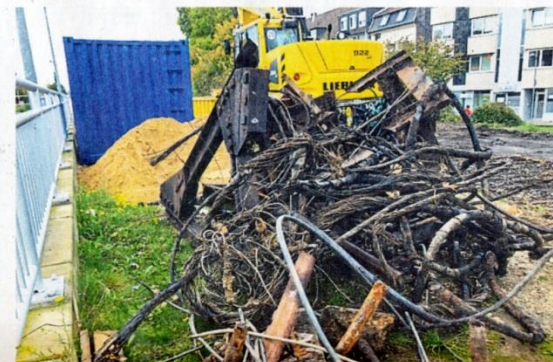
Der alte Prellbock ist bereits aus seinem Fundament herausgerissen worden – genau wie zahlreiche Seile.
