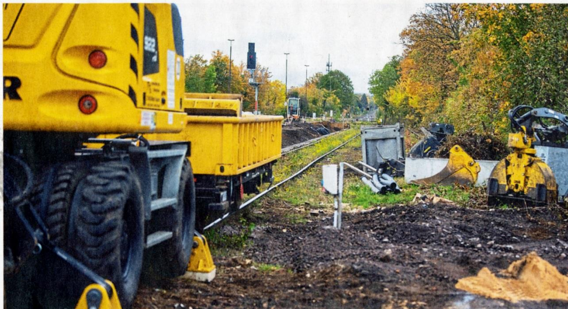
An diesem Gleis im Euskirchener Bahnhof soll schon bald die Bördebahn ankommen und auch wieder abfahren.
